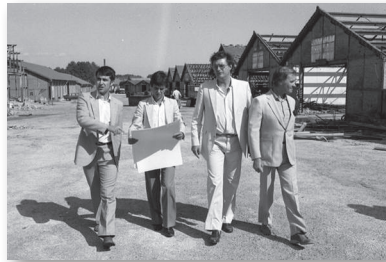
Visite du chantier Antigone avec G. Frêche, R. Bofill et R. Dugrand, 1979
