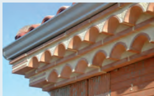
Corniche en brique
