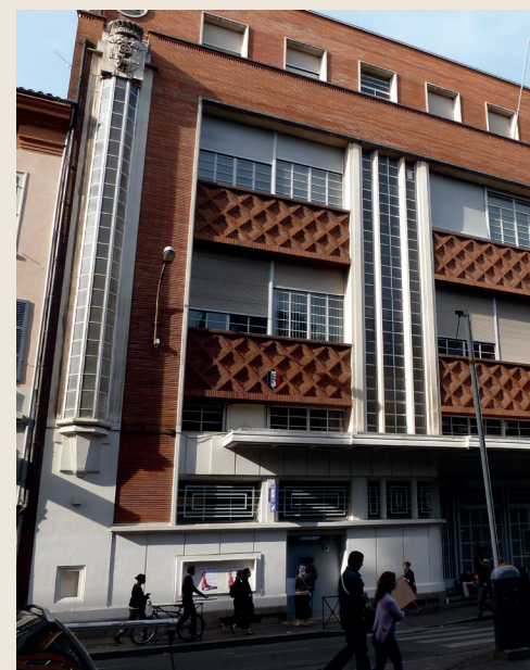
Poste centrale (rue Lafayette)
