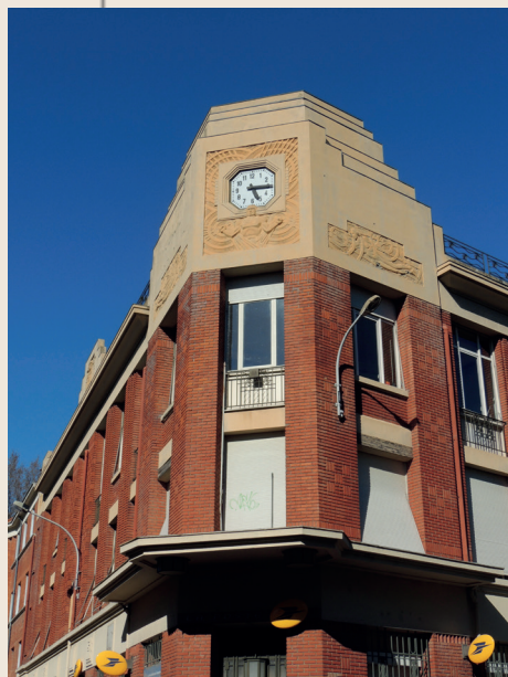
Saint-Aubin : bâtiment de la direction des PTT et central téléphonique
